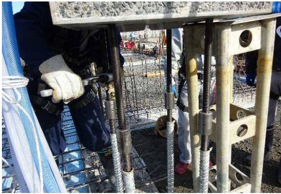
②-1 基礎・柱のPC鋼棒を接続
