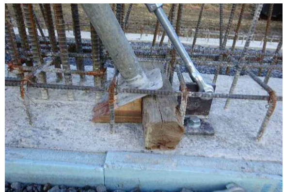
写真-12 サポート・ワイヤー基部
