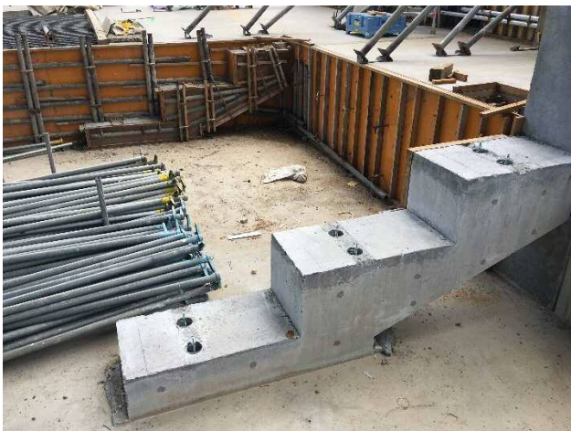
写真-13 PC 段床版架設前状況
