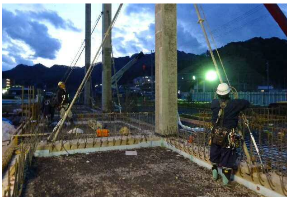
写真-11 サポート・ワイヤー設置状況
