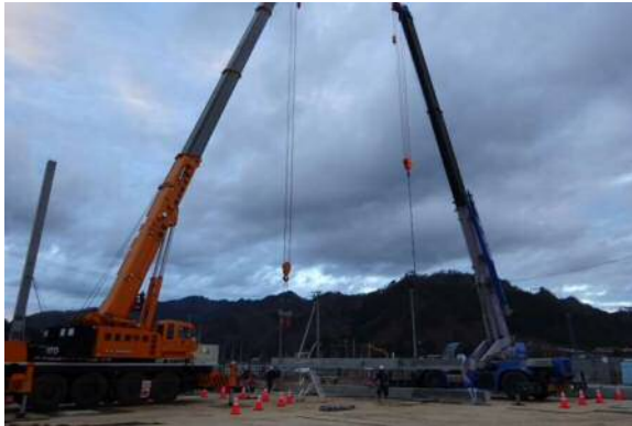
①柱部材を水平に合吊り
