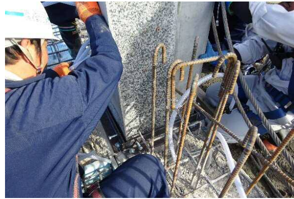
②-2 柱の据え付け
