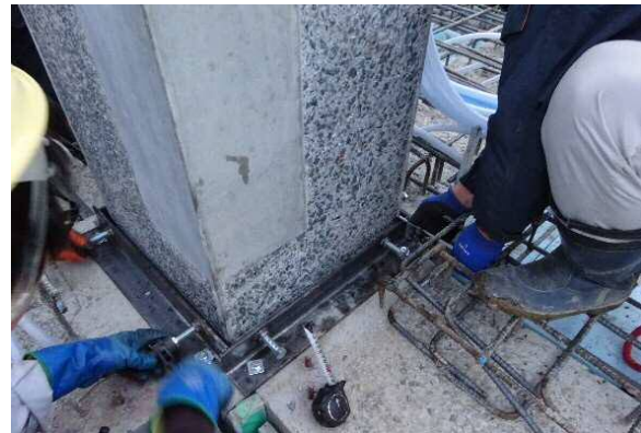
写真-10 柱脚位置調整状況
