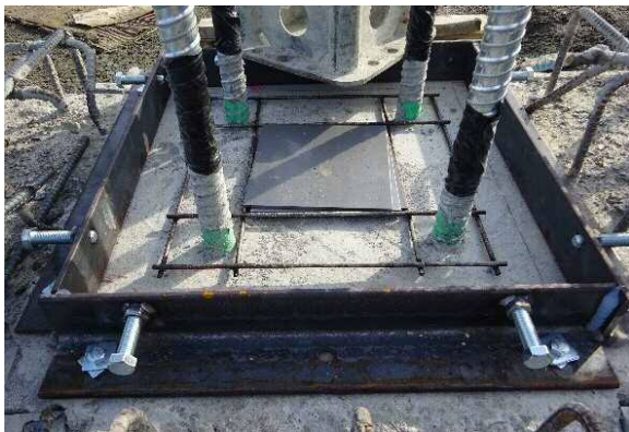
写真-9 柱脚位置調整金物
