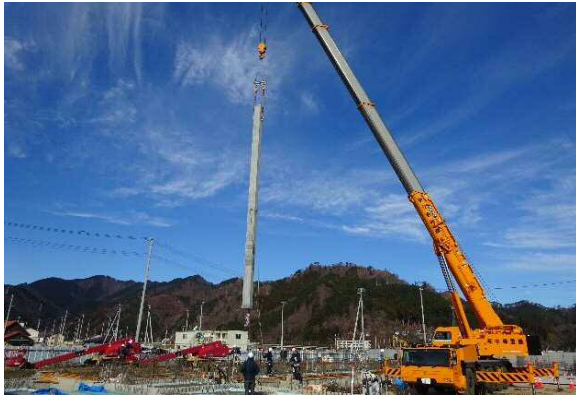
①-1 所定の据え付け位置へ部材移動
