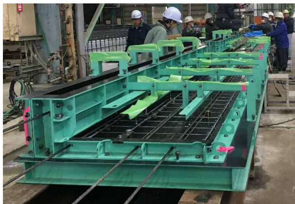
写真-5 PC 段床版製作状況
