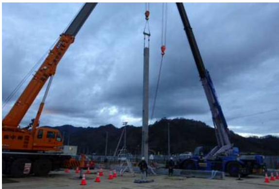
③建て起こし完了
