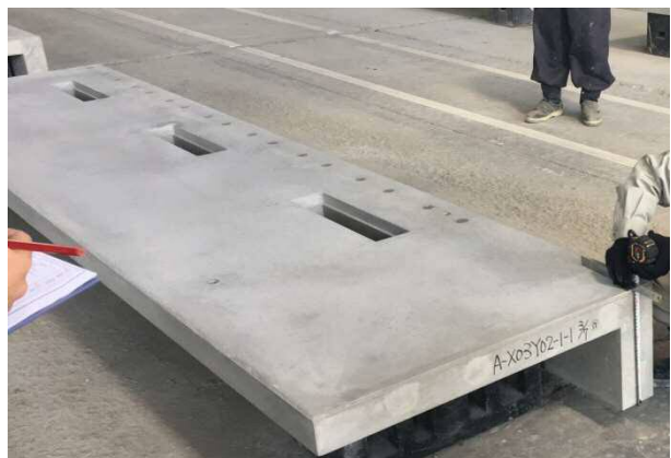
写真-6 PC 段床版出来形
