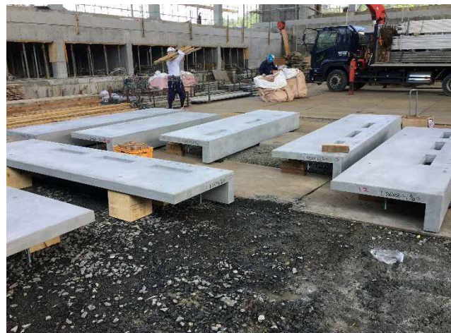
写真-14 PC 段床版現場内仮置き状況
