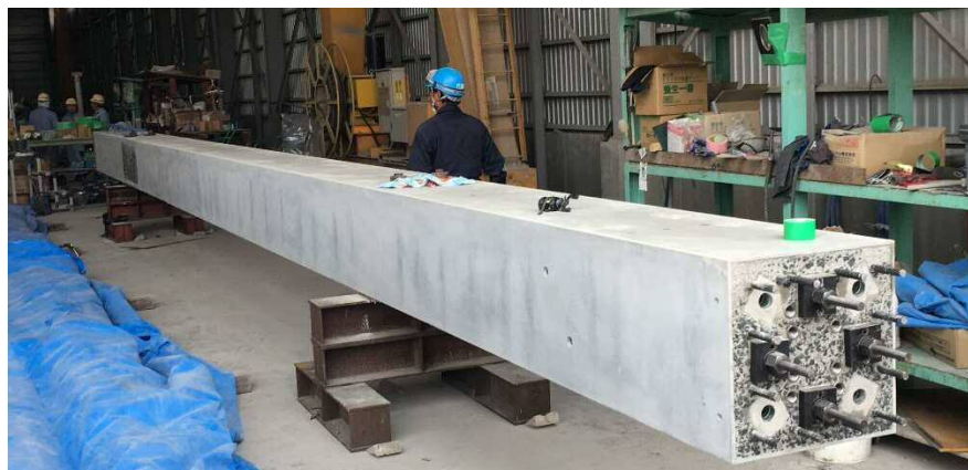
写真-4 PCaPC柱出来形(柱頭側)
