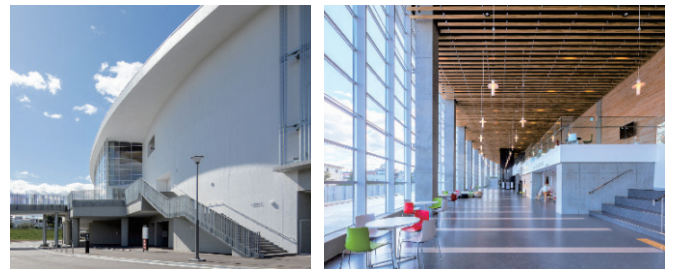
写真-5 外周大庇(PCスラブ)
