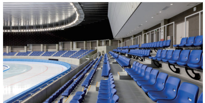
写真-7 メインスタンド(PC段床部)
