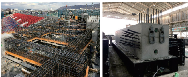
写真-4 円弧区間現場配筋状況 写真-5 くの字主筋打込状況
