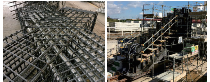
写真-6 X型柱の配筋状況 写真-7 段梁の型枠・配筋状況
