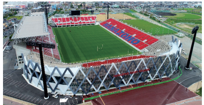
写真-1 改修後のラグビー場全景（南 SS 南西側から空撮）
