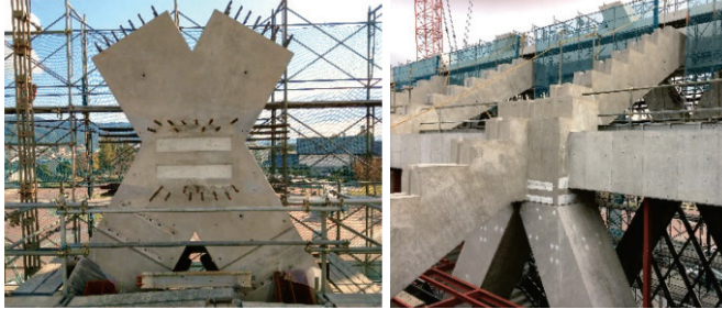
写真-2 X型柱の架設後状況 写真-3 斜め柱と段梁の取合
