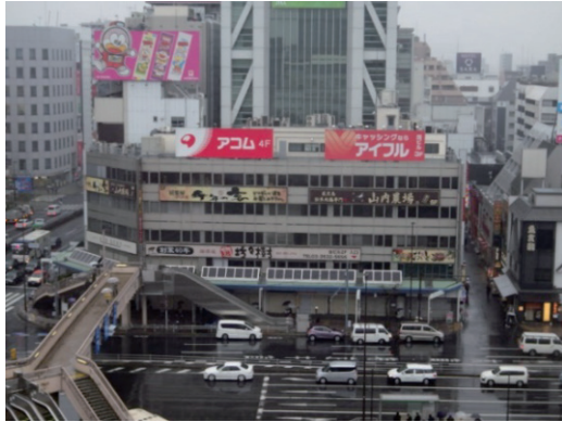
写真-2 既存建物外観
