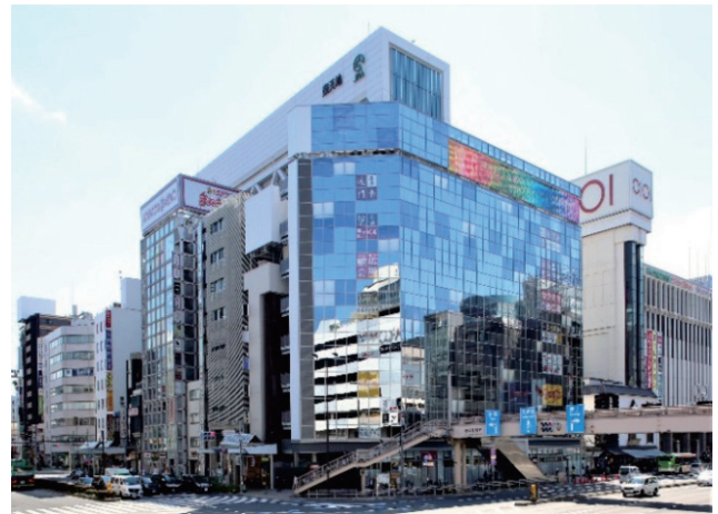
写真-1 新設建物外観
