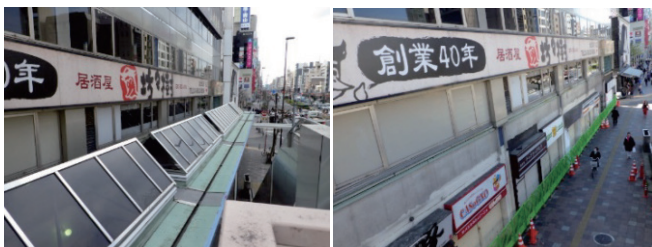
写真-3 アーケード解体前後
