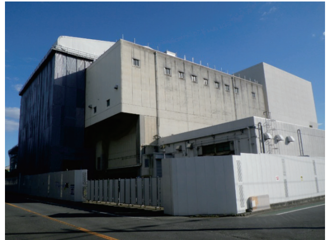
写真-1 既存 2 号炉外観
