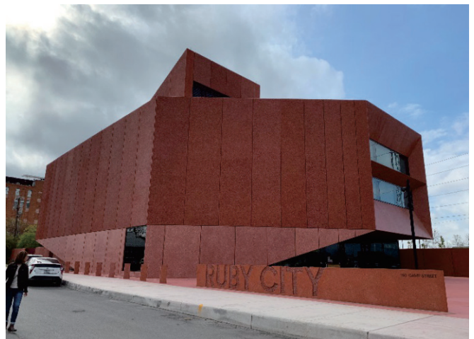
写真-5 ルビーシティ外観
