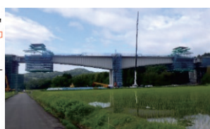
写真-3 張出し架設状況
