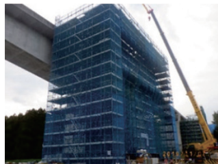
写真-2 柱頭部支保工
