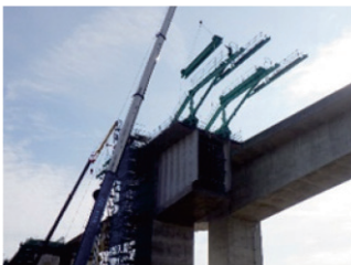
写真-1 移動作業車組立状況
