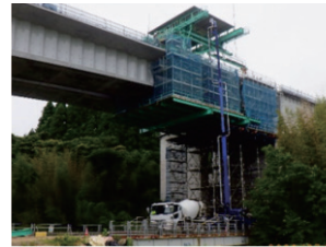
写真-4 A1側閉合部施工
