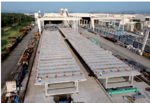
写真-1 プレキャストセグメントの仮置き状況
