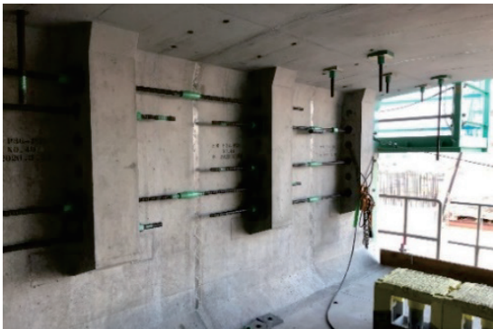
写真-2 引寄せ鋼棒の配置状況
