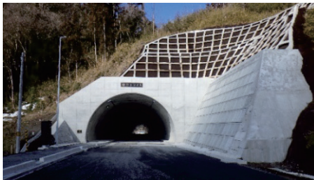
写真-1 起点側坑門部
