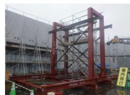
写真-1 山留材組立状況
