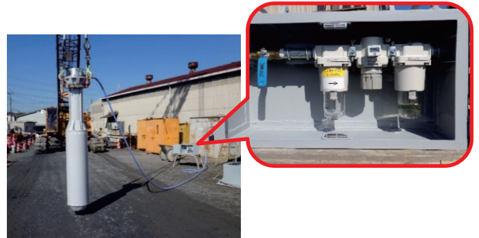
写真-3 改良されたパイプレータートレミー (左)
