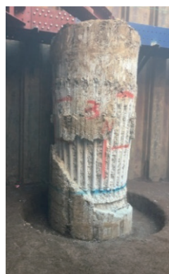
写真-1 流動性の悪いコンクリート杭頭の例 (左)
