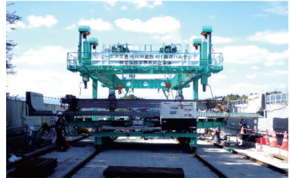
写真-1 床版取り込み状況
