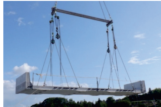
写真-1 版吊り上げ状況
