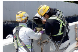
写真-4 壁高欄目地モルタル充填
