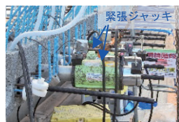
写真-6 緊張状況
