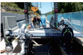
写真-3 床版架設状況
