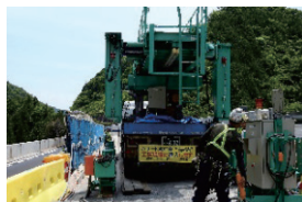
写真-2 架設機の組立
