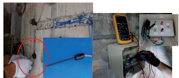
写真-4 チタンワイヤーセンサーの設置および計測状況
