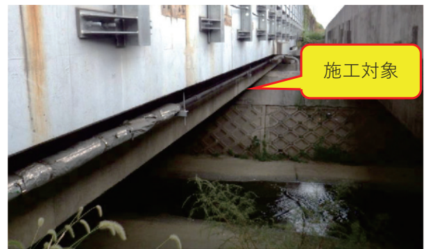
写真-1 対象橋梁の外観
