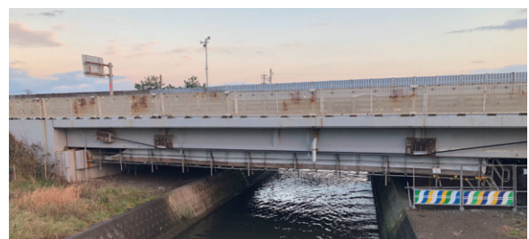
写真-1 施工対象の橋梁
