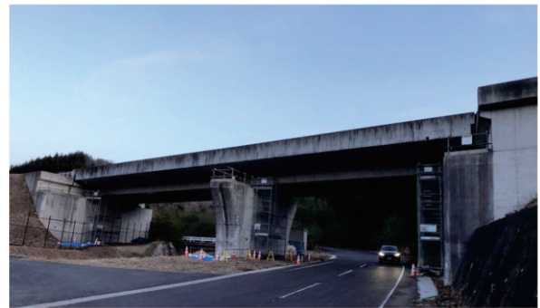
写真-1 拡幅前の暫定供用状況
