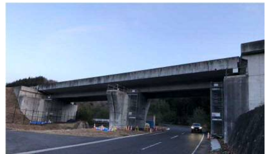
写真-1 拡幅前の暫定供用状況
