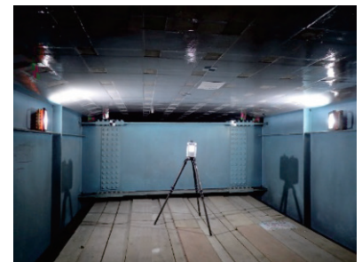
写真-6 スキャナー B によるデータ取得状況
