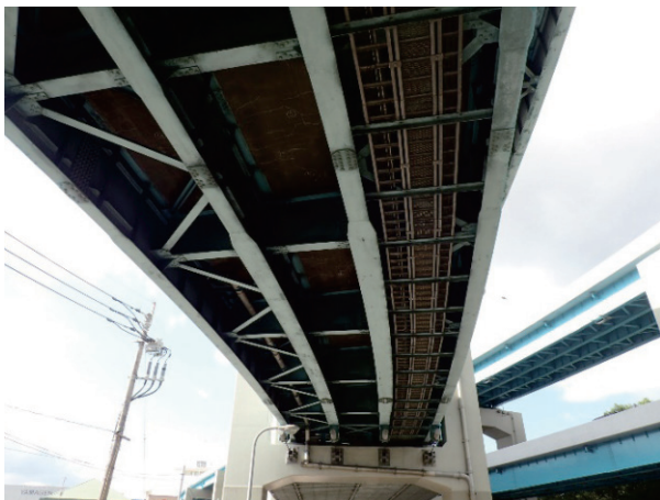
写真-1 鋼桁とコンクリート床版
