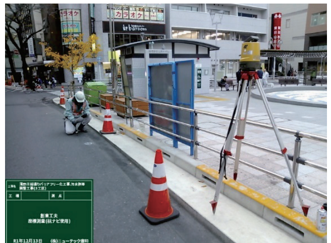
写真-3 杭ナビ測量状況
