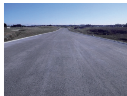
写真-3 上層路盤転圧完了状況
