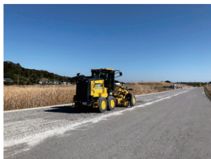
写真-2 上層路盤敷均し状況
