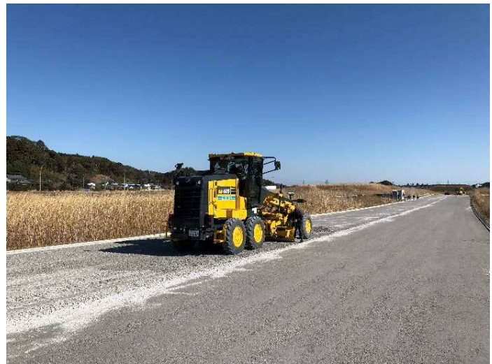
写真-4 上層路盤敷均し状況
