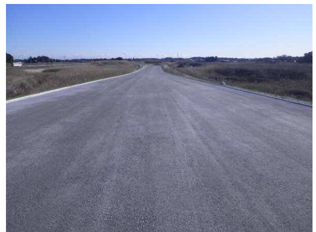
写真-5 上層路盤転圧完了状況
