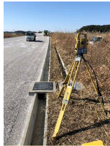
写真-3 TS 設置
