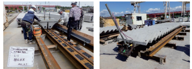
写真-4 階段組立状況 (左)・圧着接合後状況
