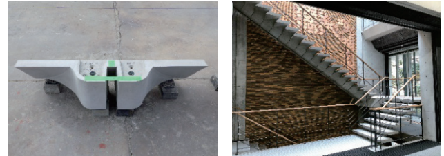
写真-3 階段版製品 (左)・完成状況
