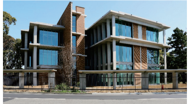
写真-1 建物外観（西面）
