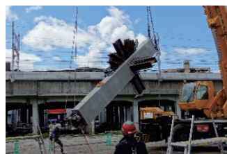
写真-2 建て方状況
