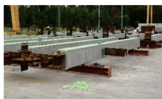
写真-4 養生状況
