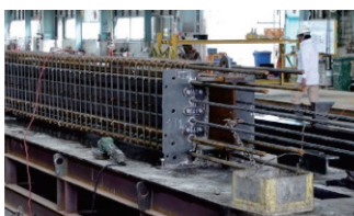
写真-3 配筋状況
