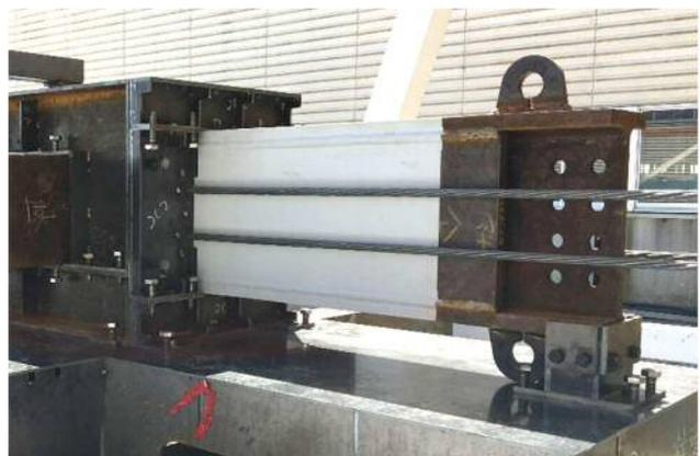
写真-3 S柱芯調整状況
