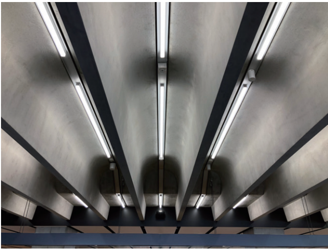
写真-2 ST板の敷設状況と照明の関係
