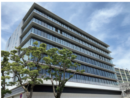
写真-1 建物外観
