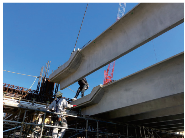
写真-3 部材架設状況
