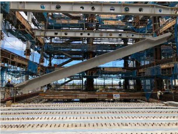
写真-6 部材架設状況 (2)
