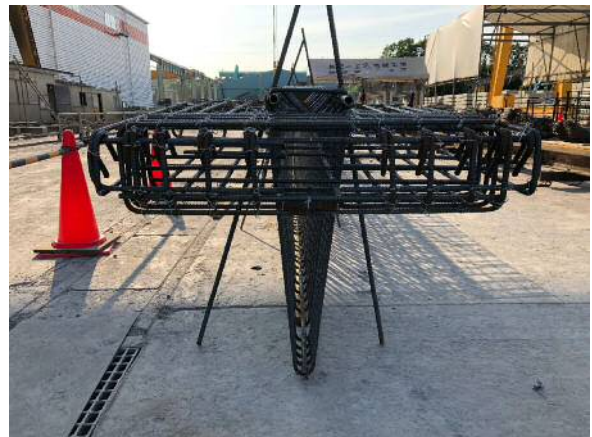
写真-4 配筋モックアップ
