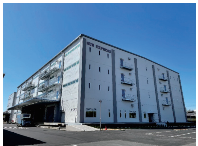
写真-2 建物外観
