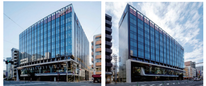
写真-1 北西側外観
