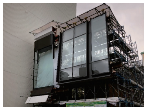
写真-3 モックアップ外観
