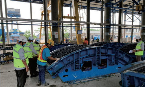
写真-1 打設前検査状況
