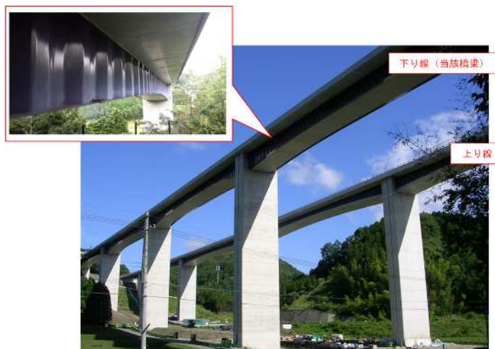
写真-1 杉谷川橋(下り線)
