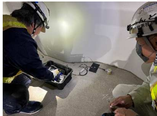
写真-2 振動計測状況
