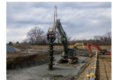
写真-2 地盤改良工 (ICT) 施工状況
