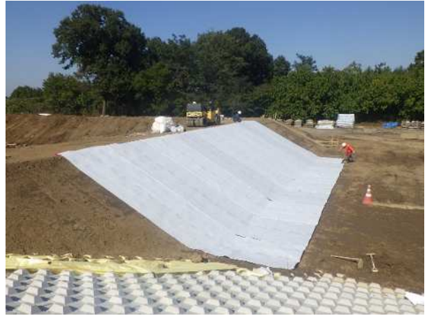
写真-2 遮水シート貼付け状況
