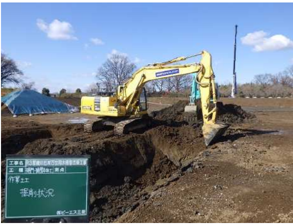
写真-5 掘削状況
