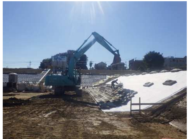
写真-3 連節ブロック据付状況
