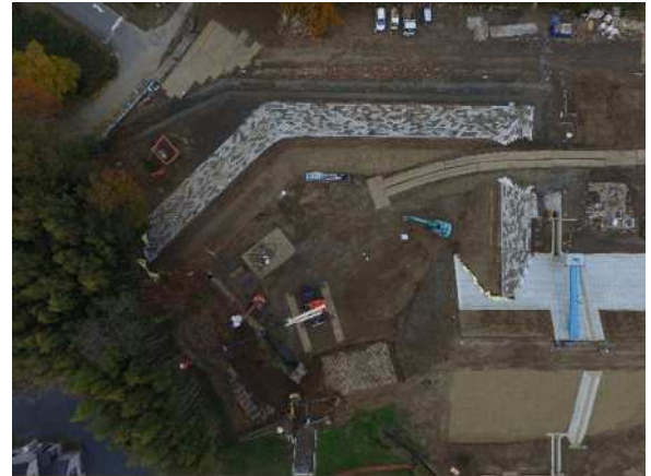
写真-5 仮締切状況 (2期)
