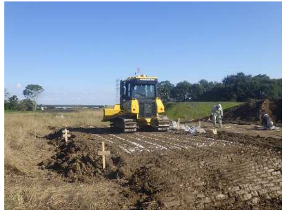
写真-4 試験盛土実施状況
