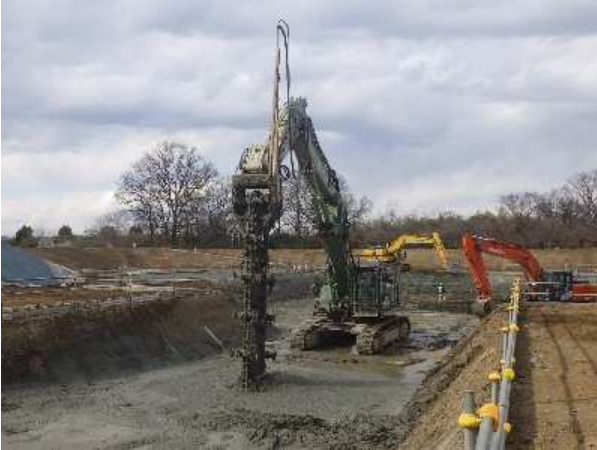
写真-7 施工状況
