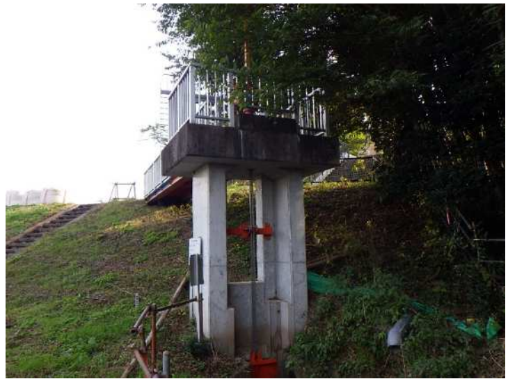
写真-1 高坂万世樋管(着工前)
