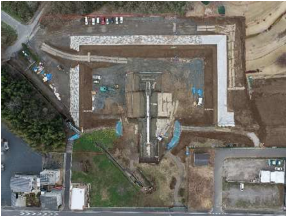
写真-4 仮締切状況 (1期)
