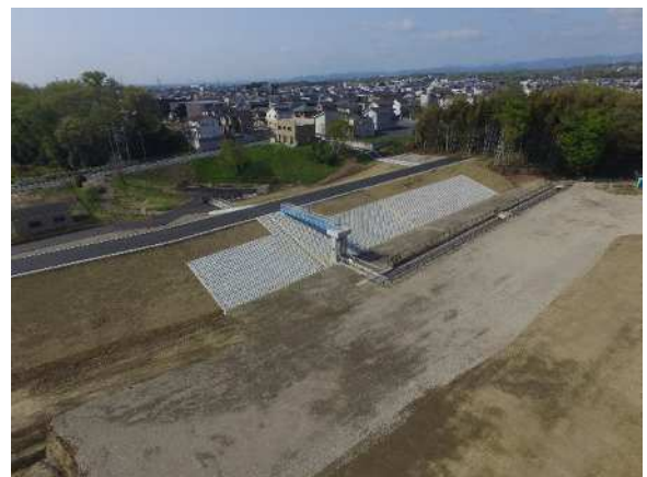
写真-9 完成写真
