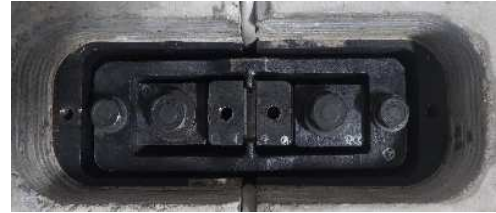
写真-1 継手組立写真 (上面より)
