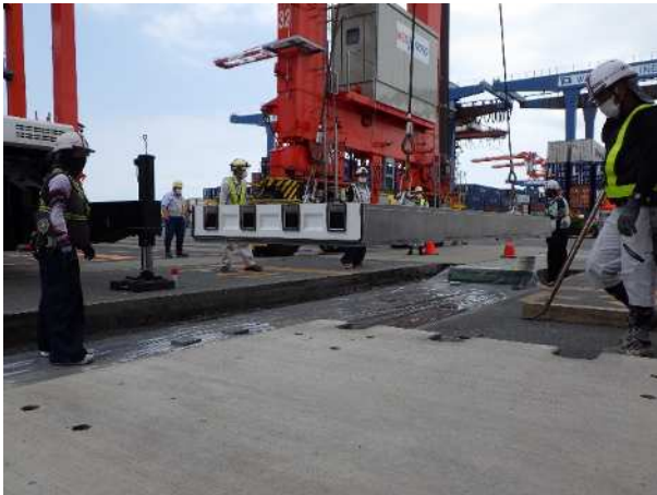
写真-6 試験体架設状況
