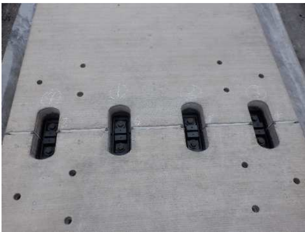
写真-8 継手接合完了
