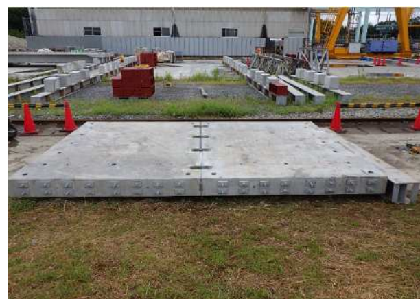
写真-13 再接合完了
