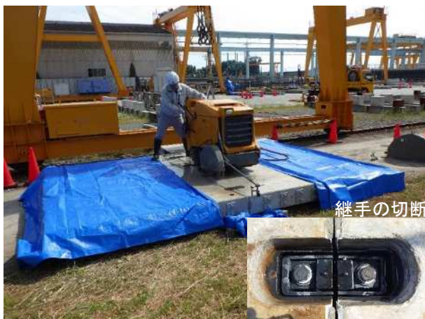
写真-10 目地切断状況
