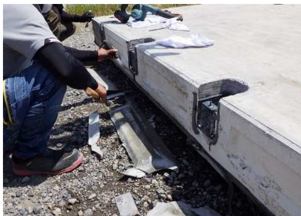
写真-12 目地部の撤去後状況
