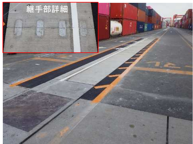
写真-9 試験施工完了
