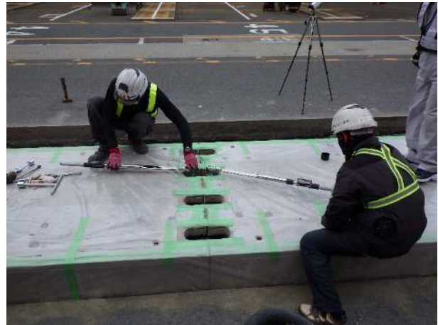
写真-7 継手施工状況
