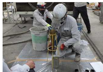
写真-3 JA 漏斗試験実施状況
