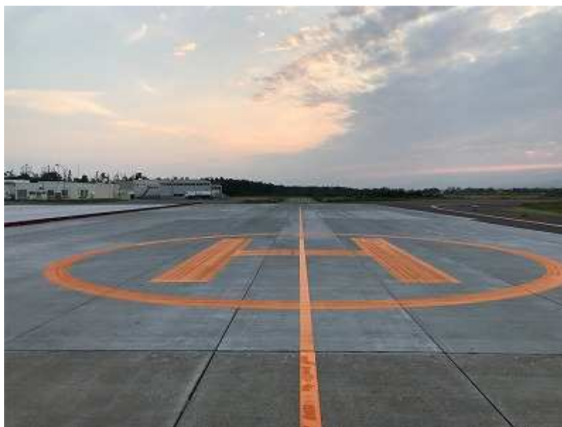
写真-9 PPC 版敷設箇所完成状況
