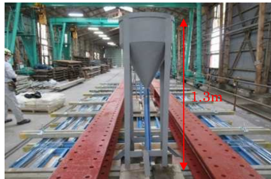
写真-2 注入用漏斗
