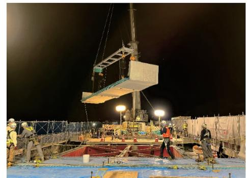
写真-1 PCaPC 床版架設状況
