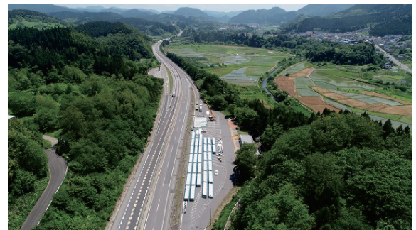
写真-1 PCaPC 床版仮置状況
