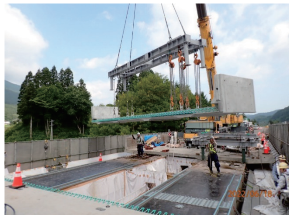
写真-2 PCaPC 床版架設状況（不動川橋）
