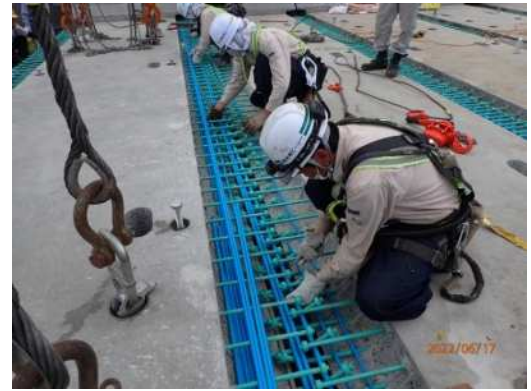
写真-4 間詰部配筋状況
