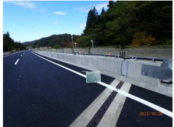
写真-6 フルキャスト壁高欄施工完了
