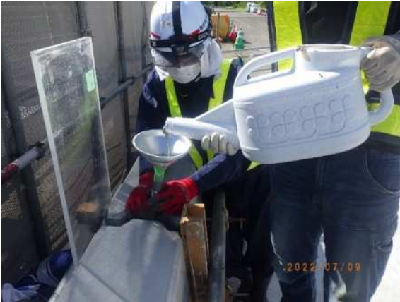
写真-5 目地部モルタル充填状況
