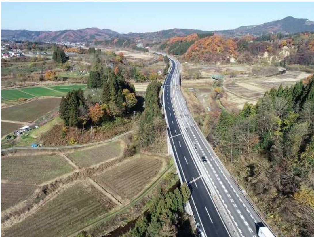
写真-7 下り線 3 橋施工完了
