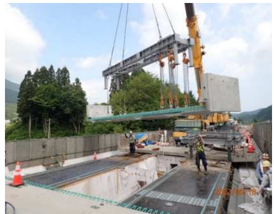
写真-3 PCaPC 床版架設状況
