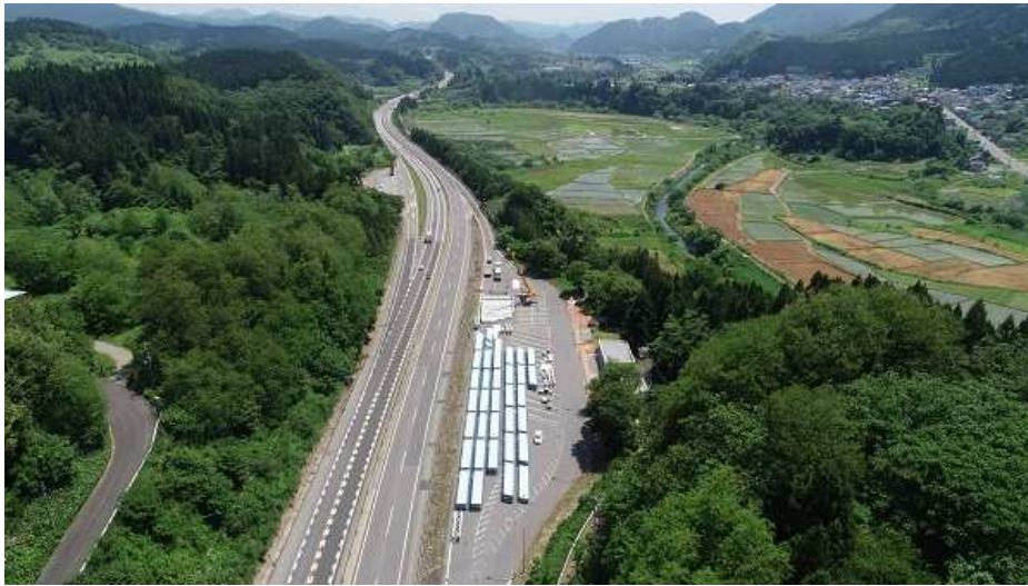
写真-2 PCaPC 床版仮置き状況（阿闍羅 PA 下り線）
