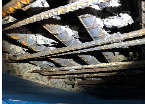
写真-2 鉄筋状況(P6～A2 径間)
