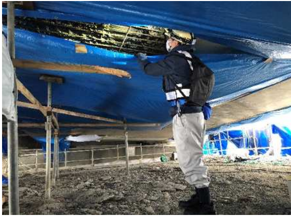
写真-1 現地状況確認(P6～A2 径間)
