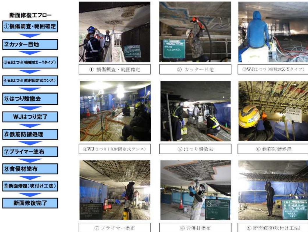
図-20 断面修復工の施工フロー
