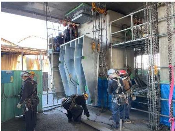
写真-3 ブラケット吊上げ状況
