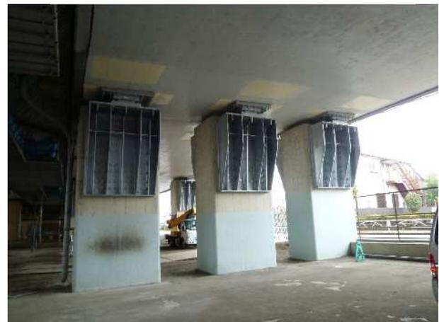
写真-4 水平力分担構造 設置完了
