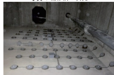
写真-2 補修後の状況
