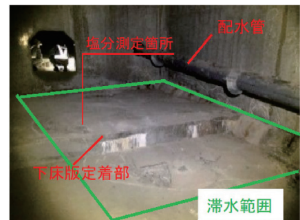
写真-1 補修前の状況
