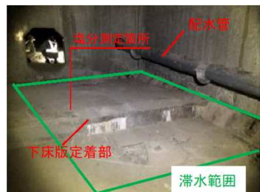
写真-2 補修前の状況
