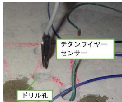
写真-4 チタンワイヤー センサー設置
