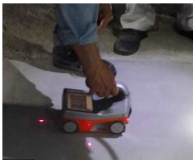
写真-3 事前調査工
