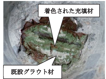
写真-1 着色された充填材の充填状況
