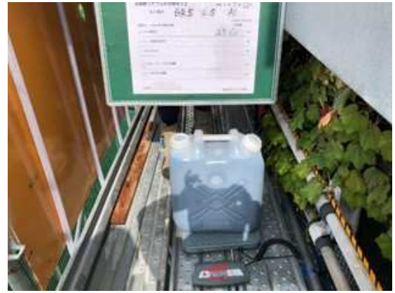
写真-2 垂硝酸リチウム水溶液注入量の計測状況
