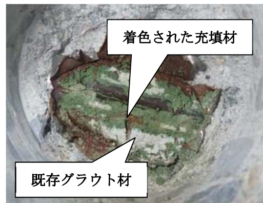
写真-6 着色された充填材の充填状況
