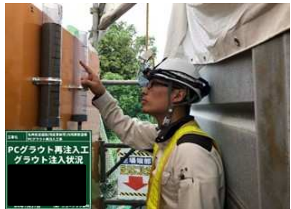
写真-3 垂硝酸リチウム添加充填材充填量の計測状況
