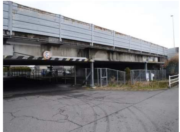
写真-1 内阿原避溢橋
