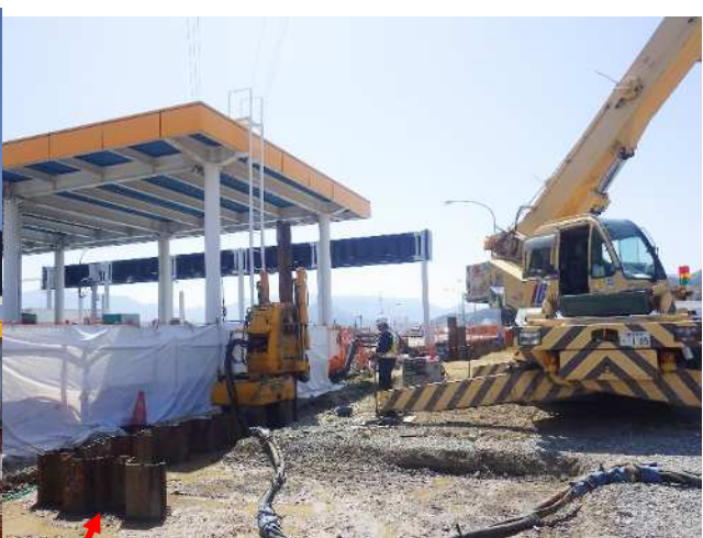
写真-7 山留施工状況
