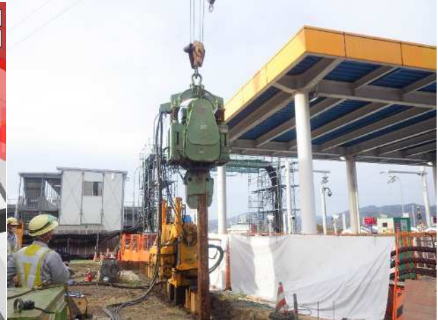
写真-5 山留施工状況
