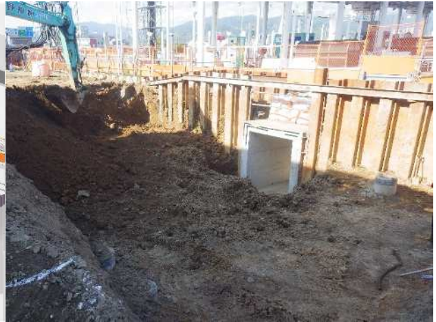
写真-8 料金所地下通路部掘削状況
