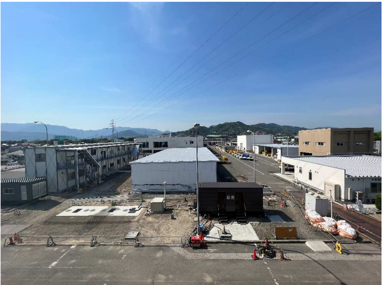
写真-2 松山 IC 管理施設(立体駐車場棟屋上から南を望む)
