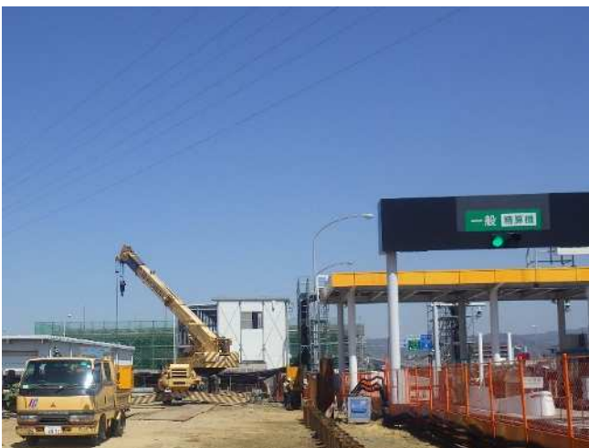
写真-6 山留施工状況
