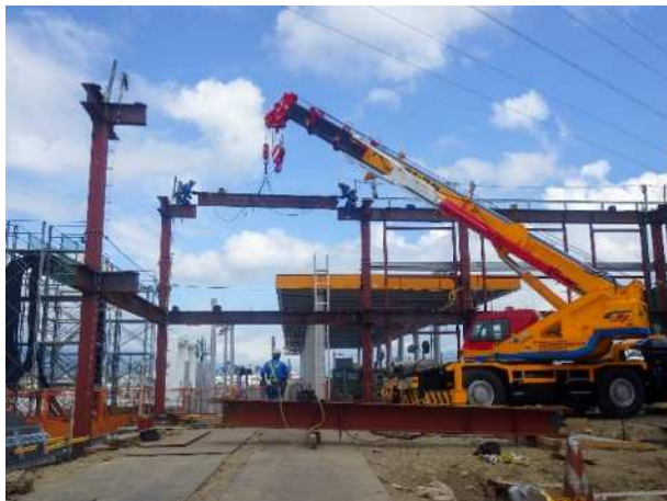
写真-4 鉄骨建方状況
