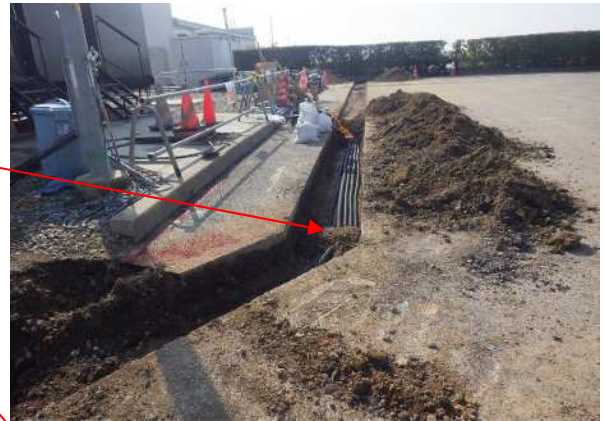
写真-9 埋設配管折り曲げ計画位置
