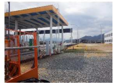
写真-13 事務所着工前
