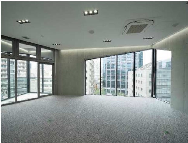
写真-6 テーパー梁下サッシ設置状況
