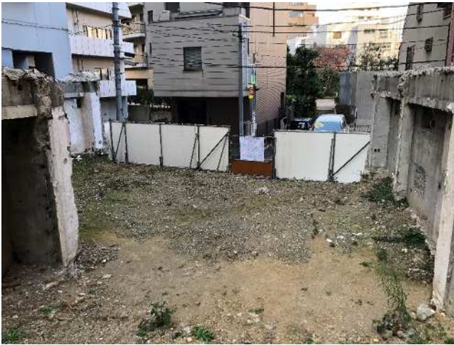
写真-4 既存建物残置状況
