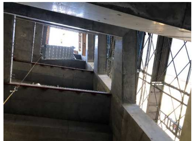
写真-11 鉄骨階段建方状況
