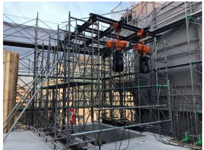
写真-10 鉄骨階段建方用櫓状況
