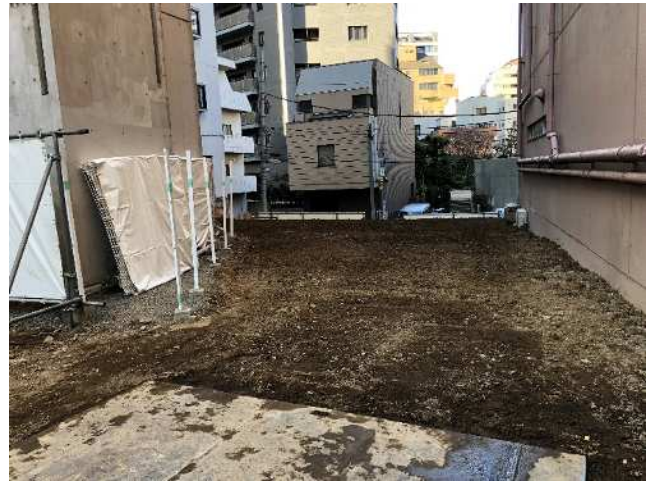
写真-5 盛土状況
