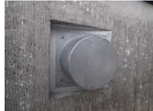
写真-9 鋼製製グラウトキャップ
