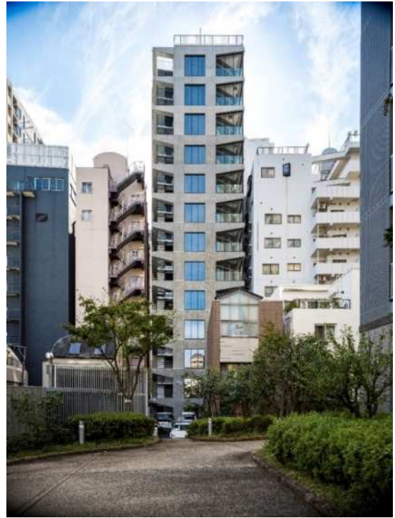
写真-2 北側全景
