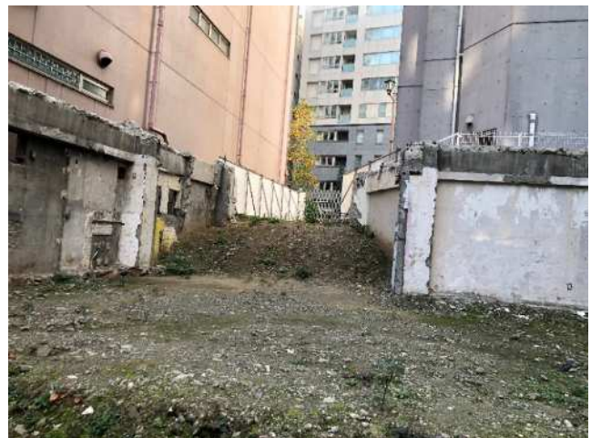
写真-3 既存建物残置状況
