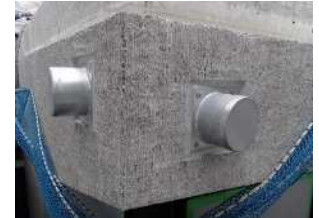
写真-9 鋼製製グラウトキャップ
