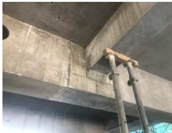
写真-8 小梁の支保工による支持端部
