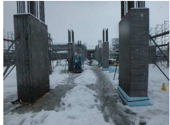
写真-4 柱脚モルタルの寒中養生状況
