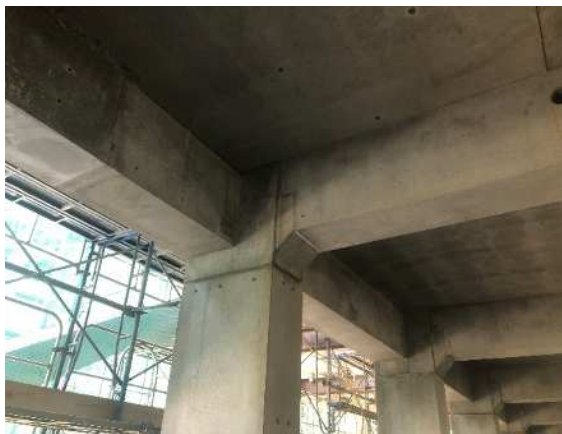
写真-7 小梁の PCa 側支持端部
