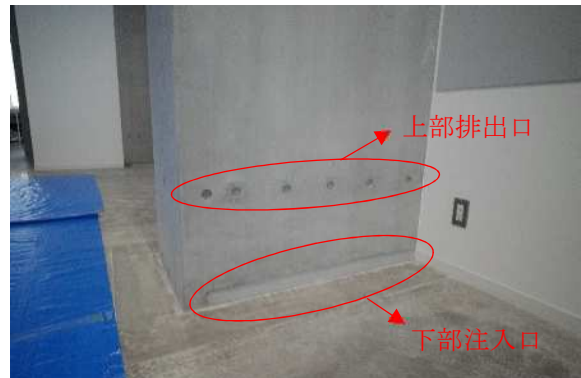
写真-2 柱脚注入孔座掘の巾木風仕上げ
