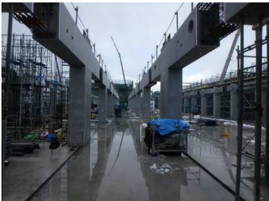
写真-5 レンコン方式桁梁
