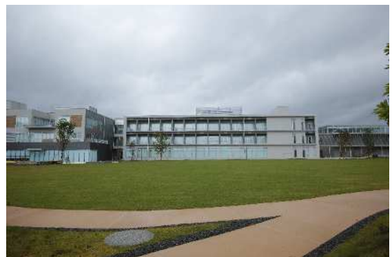
写真-1 外観写真
