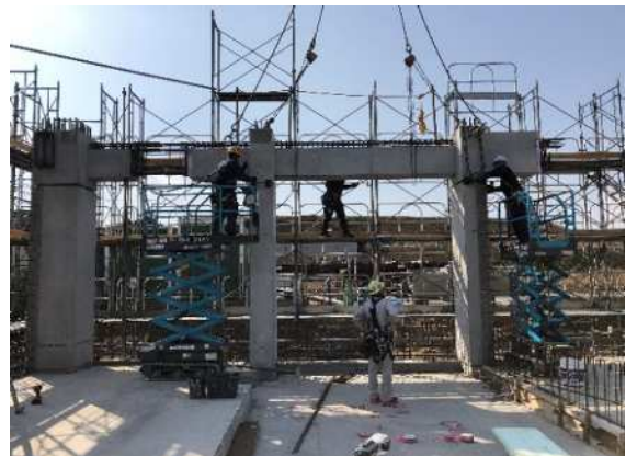
写真-6 ダブルレンコン方式スパン梁
