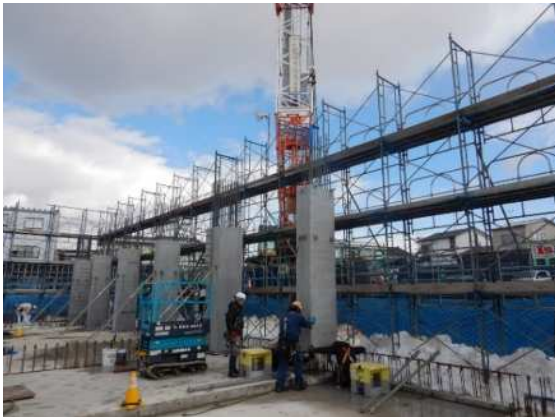
写真-3 柱の架設状況
