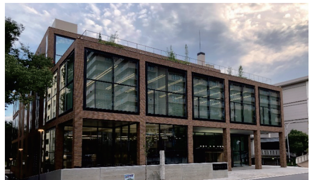
写真-1 建物外観
