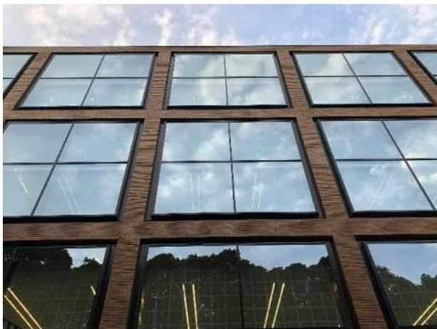
写真-5 外周 PC フレームとサッシ納まり
