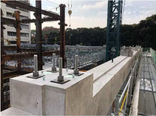
写真-3 外周 PC フレーム架設完了状況
