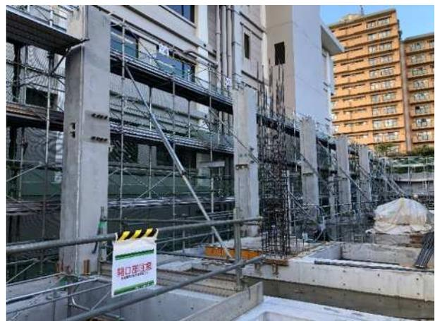
写真-2 外周 PC フレーム柱建方完了状況
